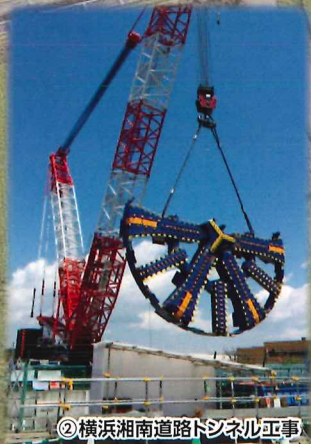
② 横浜湘南道路トンネル工事
