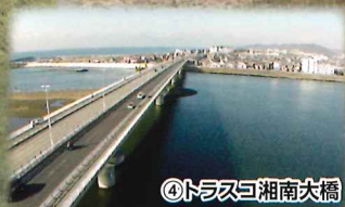
④ トラスコ湘南大橋
