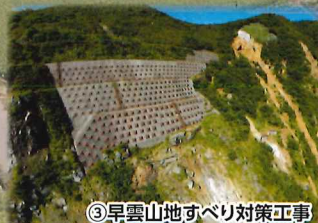
③ 早雲山地すべり対策工事
