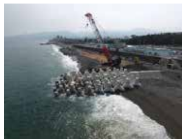
【国府津海岸 突堤工事】
