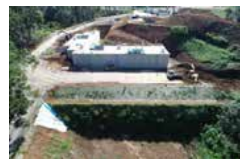
舞岡墓園整備工事
