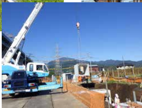
市道603号 → 道路改良工事
