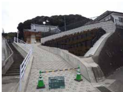
参道改修工事
