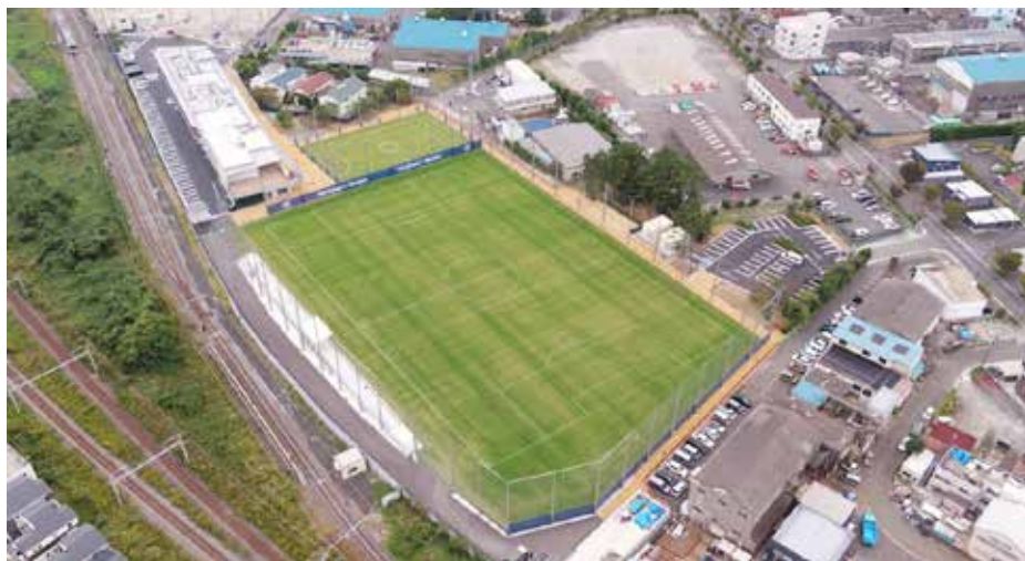
横浜F・マリノス久里浜練習場（仮称）第1期工事【令和4年竣工】
