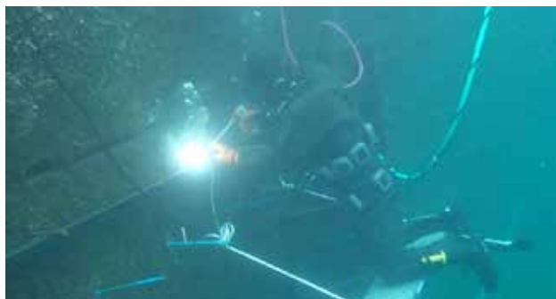
水中型枠用 (セパ水中溶接状況)
