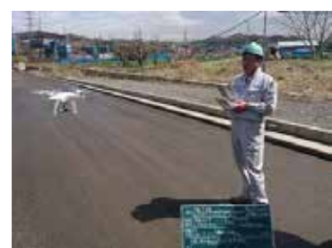
【県道603号 ドローンによる空撮調査】
