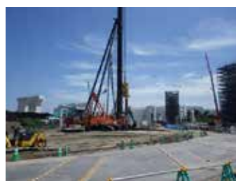
IC,JCT 整備工事
