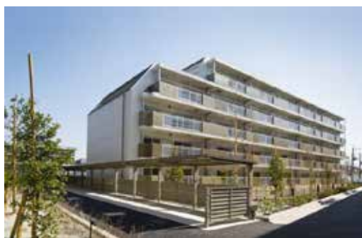
中野島住宅1号棟（2022.3月竣工）
