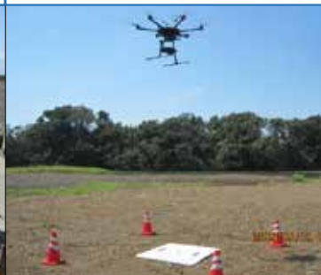
河川改修工事(下土棚) 〈神奈川県優良工事局長表彰〉
