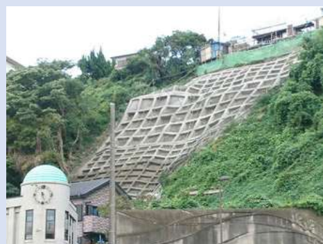
急傾斜地崩壊対策工事
