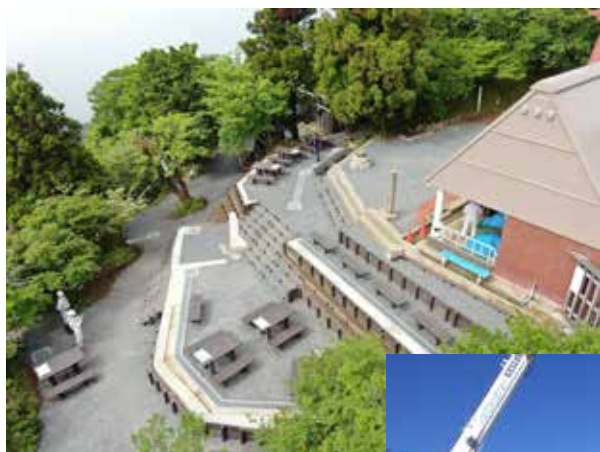
↑ 大山山頂広場 整備工事
