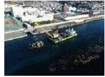
【湯河原海岸 高潮対策工事】
