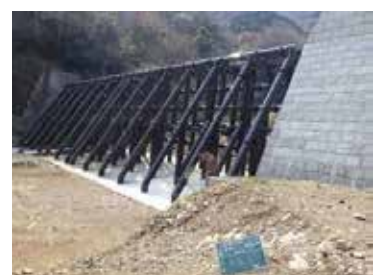
【新崎川 砂防堰堤工事】
