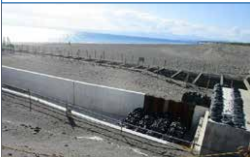
辻堂南部放流管築造工事(その3) 〈藤沢市優良工事表彰〉
