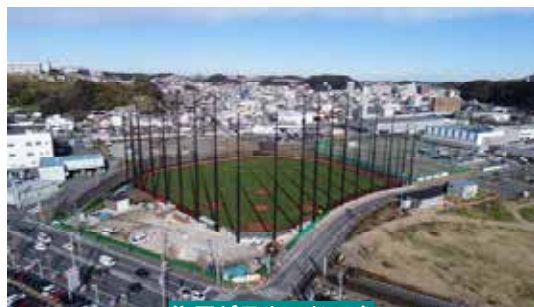
佐原グラウンド工事
