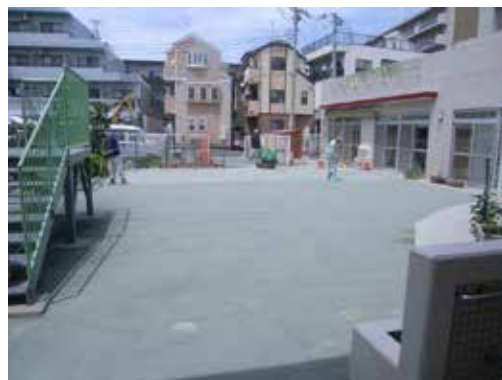
園庭整備工事
