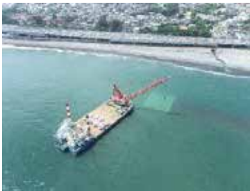
【小田原漁港海岸 人工リーフ整備工事】
