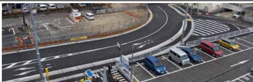
新病院建設に伴う道路改良工事
