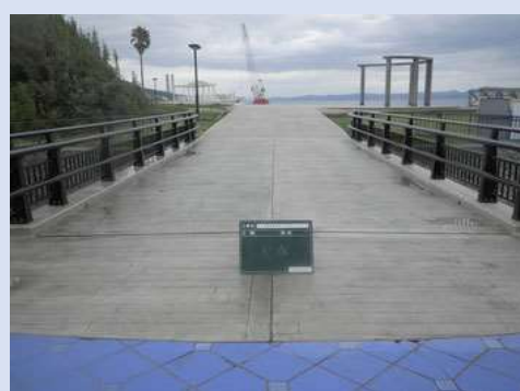
橋りょう改修工事
