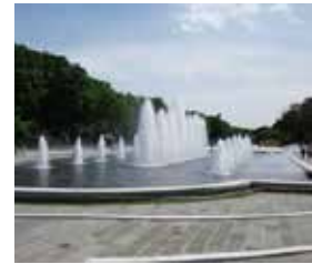
↑上野恩賜公園噴水池整備工事
