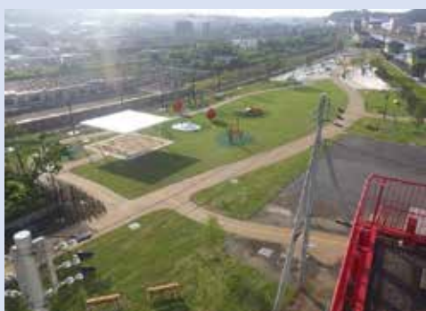
公園施設整備工事
