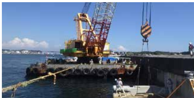
ブロック据付状況
