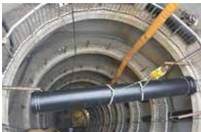
上下水道整備工事
