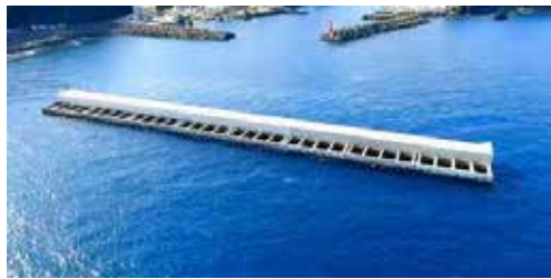
【真鶴港 沖防波堤工事】
