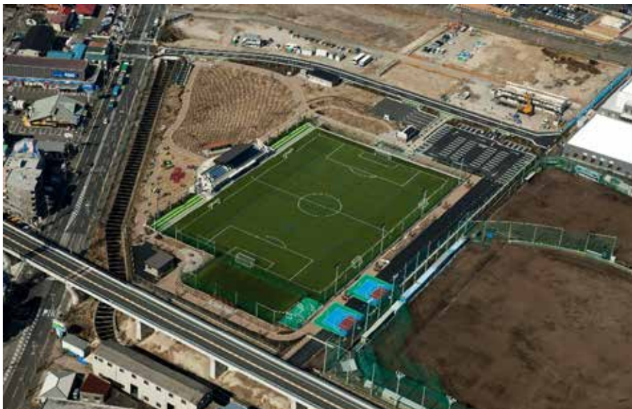
佐原2丁目公園整備工事【平成25年竣工】
