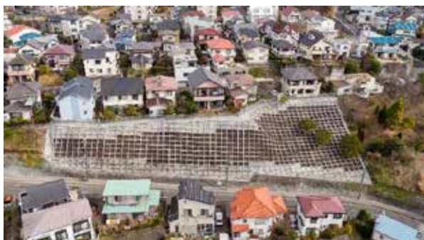
急傾斜地工事
