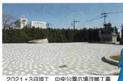
2021・3月竣工 中央公園広場改修工事
