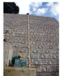
砂防工事の施工
