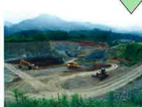
③ 埋立て・敷均し状況
