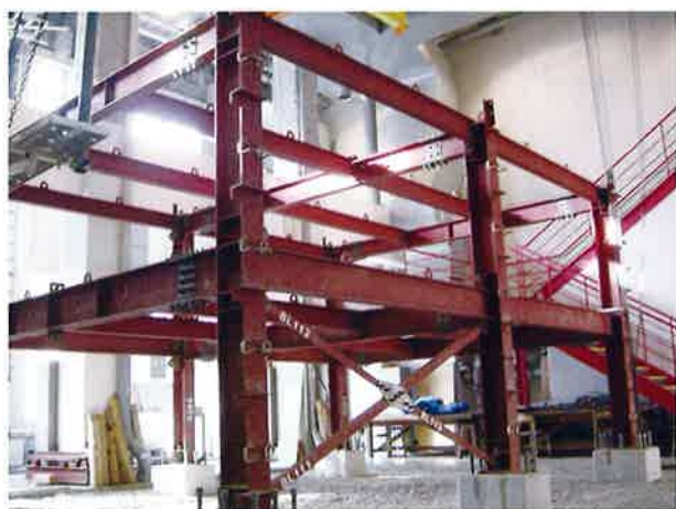
建設科実習（鉄骨組立実習風景）
