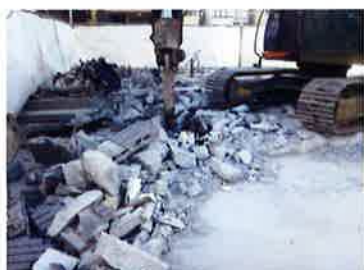
解体工事で発生したコンクリート塊
