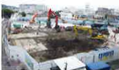
戸塚駅の再開発に関する解体工事
