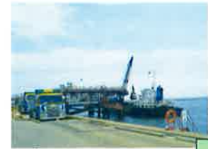
① 土運船への積み込み状況
