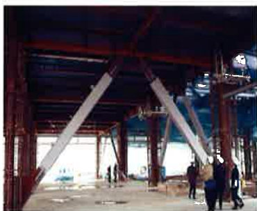
写真1：座屈拘束ブレースの施工例（物流倉庫）
