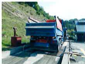
④ タイヤ洗浄状況
