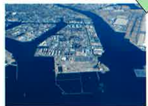
② 海洋埋立て（全景）
